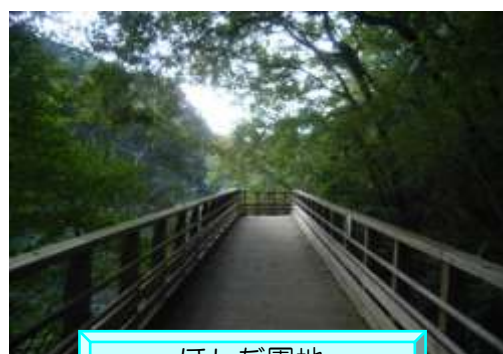
ほしだ園地 森林鉄道風歩道橋
