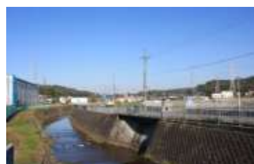
8 国道168号(北田原駐在所前)
